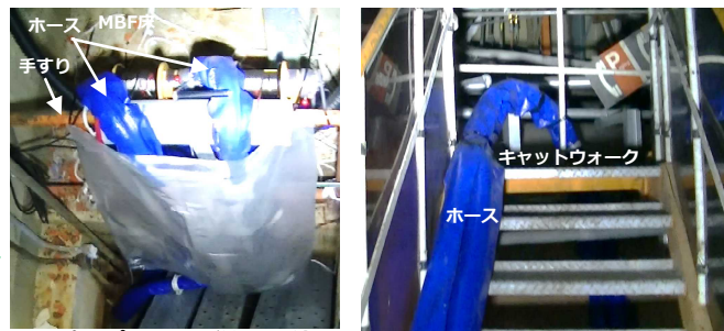
3号機R/B南東コーナー仮設排水設備の設置状況
