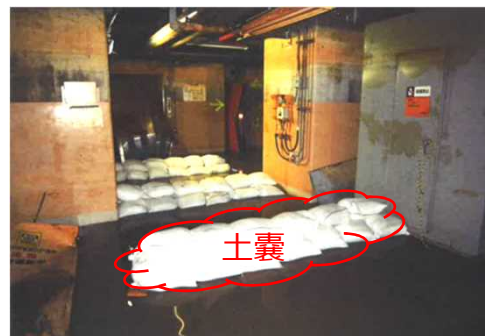
②HTIの土嚢設置時の状態
