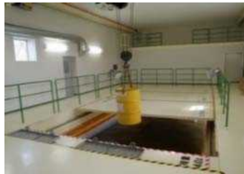
天井クレーンによる 保管体取出
