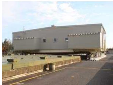
保管体取出装置 (1ピット全体を覆う構造)
