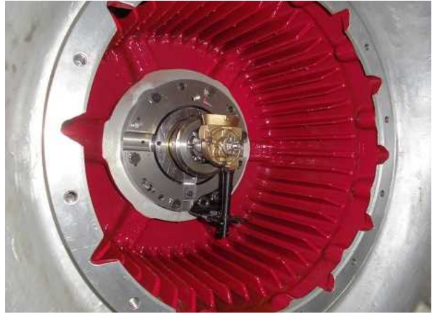
L側過給機 (ブロワ側)
