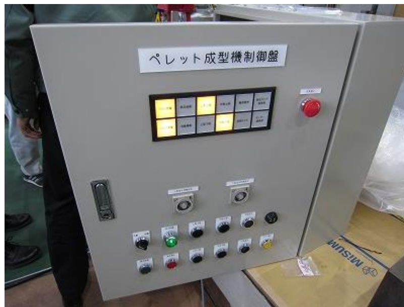
図 10.1-27 圧縮成型機用制御盤写真(1)
