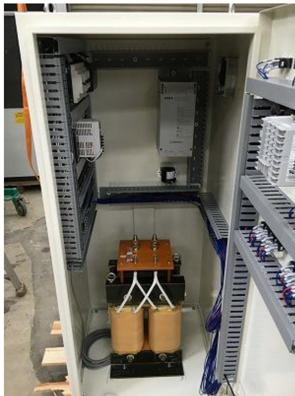
图 10.1-31 烧结炉本体用温度控制操作盘写真(2)
