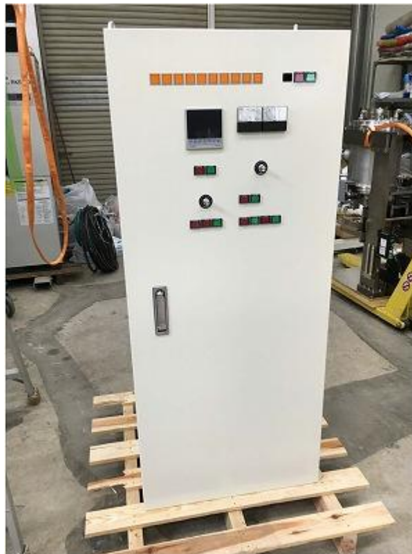
図 10.1-30 焼結炉本体用温度制御操作盤写真(1)
