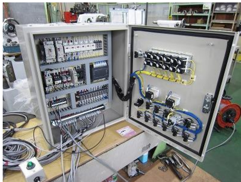
図 10.1-28 圧縮成型機用制御盤写真(2)
