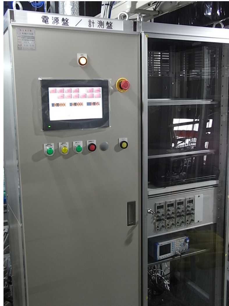
図 52 制御盤及び計測盤
