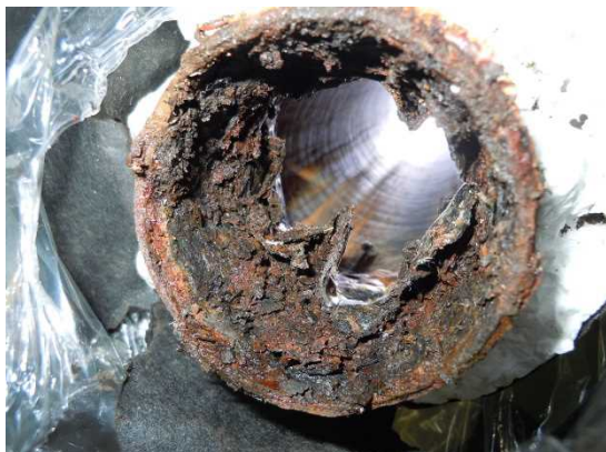
断面写真 3. 堅管の継手との接続部
