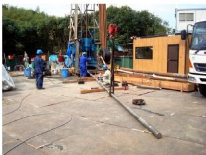
大深度ワイヤライン式の測定現場
