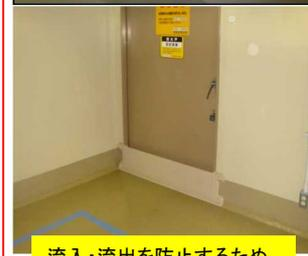
流入・流出を防止するため、浸水防止堰を設置
