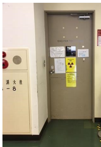
点火装置試験室
