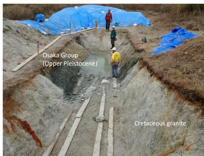
図 2.1.5. 野島セグメントを切るトレンチ。南西側から北西方向を望む。黄色の服の人物の手前の白い岩体が変質した都志川花崗岩、この人物のあたりの青緑の壁面が富島層の未固結シルト、その向こうの白っぽい部分が富島層の未固結砂礫層。主断層面は富島層の側に傾く正断層。富島層は北西にゆるやかに傾く。
