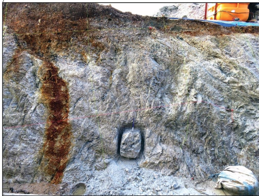
図 2.2.3. 小倉トレンチ南面壁面における岩石試料採取地点
