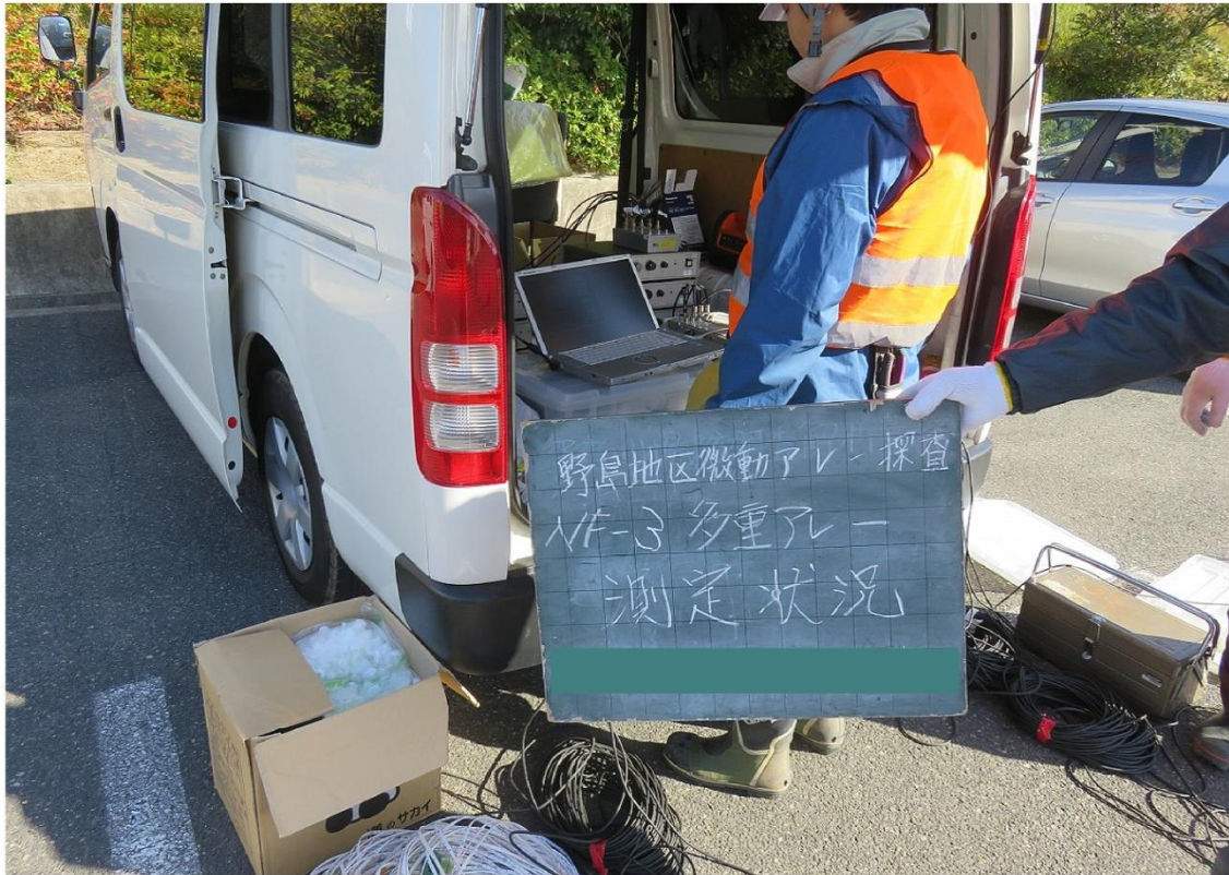
測定状況の例
