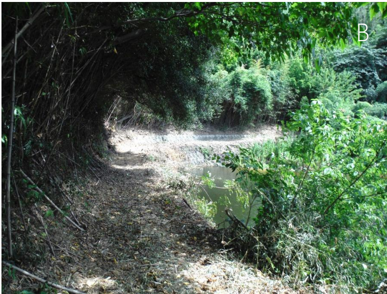
図 2.2.3 搬入路整備状況写真 A：搬入路整備前、B：搬入路整備後
