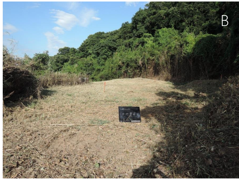
図 2.2.4 調査用地整備状況写真 A：調査用地整備前、B：調査用地整備後
