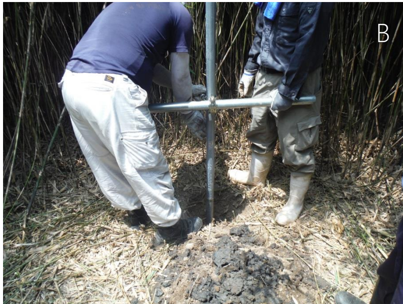
図 2.1.2 事前調査作業状況写真
