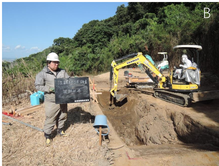
図 2.3.1.3 トレンチ掘削作業状況写真 A：表土はぎ取り状況、B：トレンチ掘削状況
