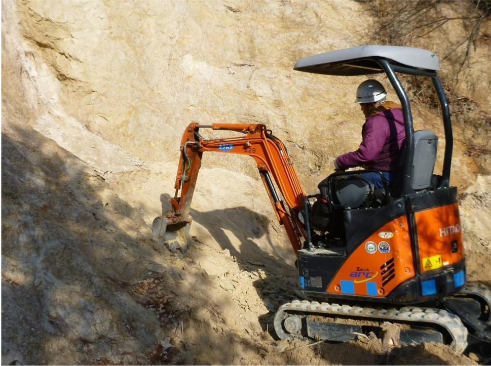
図 5.2.8 バックホウによる掘削の状況
