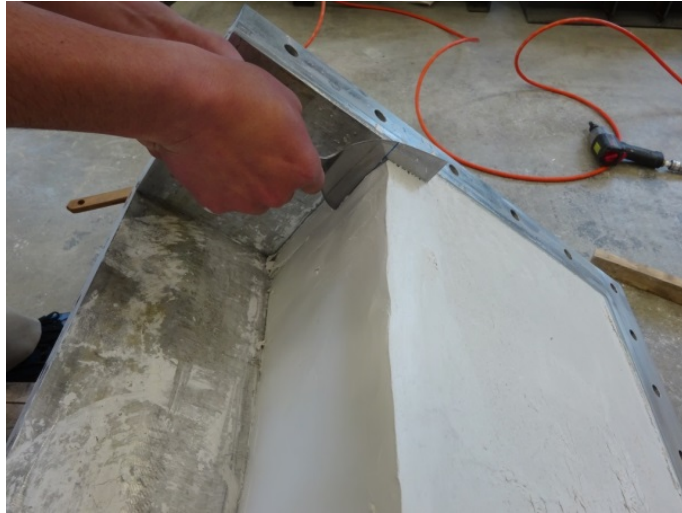
写真 3-25 フィルム挿入位置の切込み
