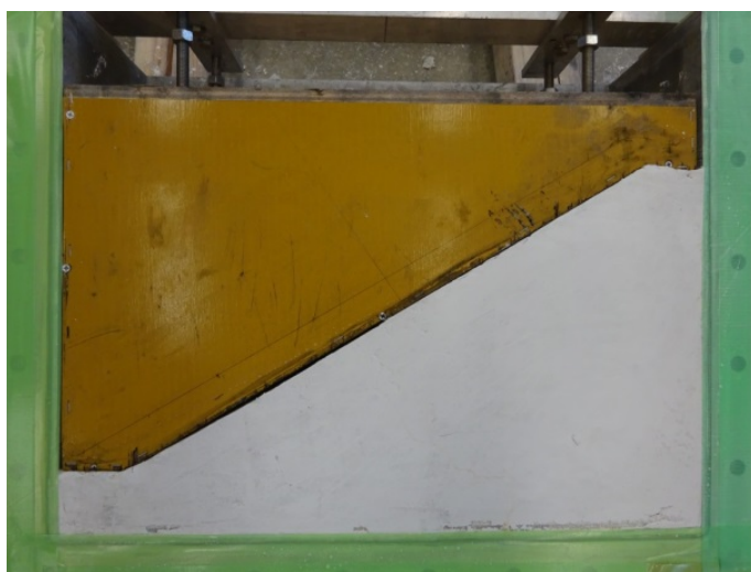
写真 3-32 崩壊防止型枠設置
