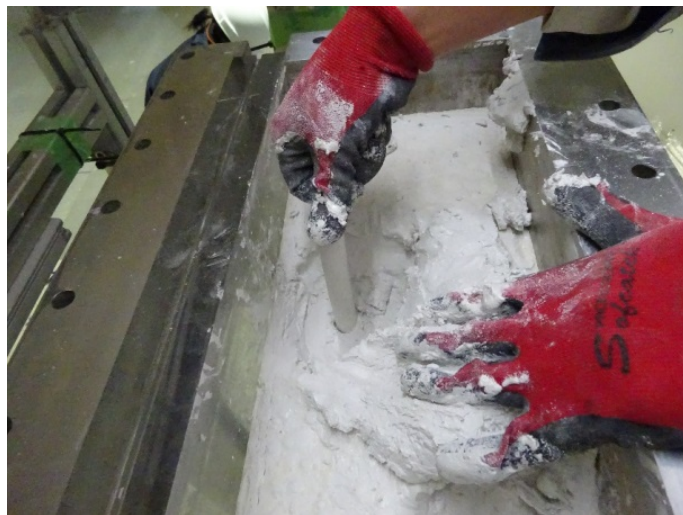
写真 3-31 サンプリング孔の穴埋め状況
