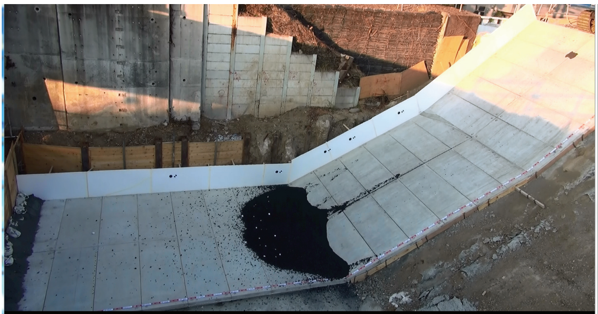
図 3.3.1.1-7 砕石の落下実験
