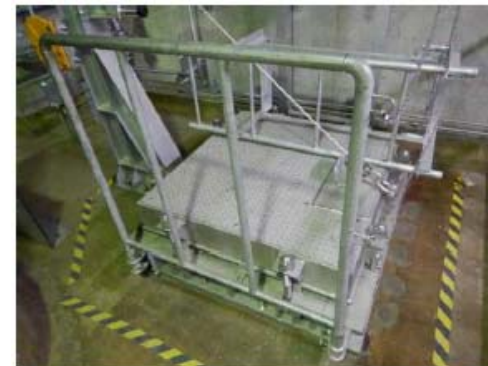
※ 浸水防止設備の例(取水槽閉止板)
