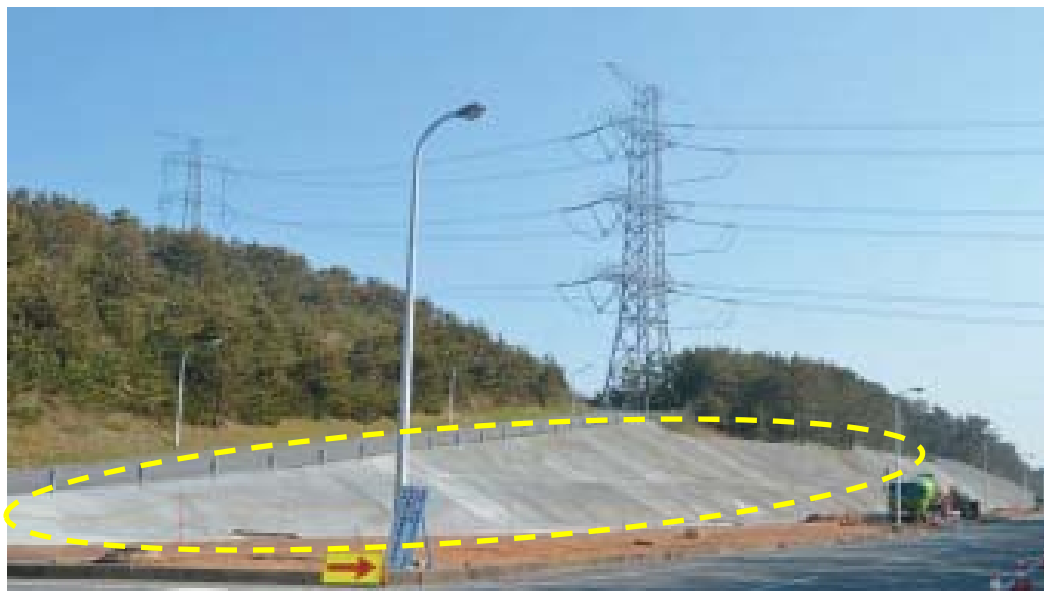
防火帯（灰色のモルタル部分）
