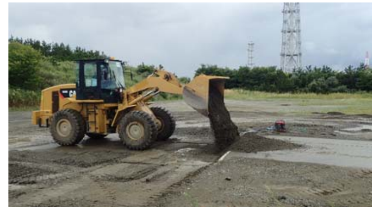
ホイールローダによるアクセスルートの復旧訓練
