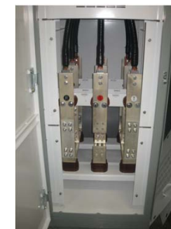
緊急用切替箱接続装置
