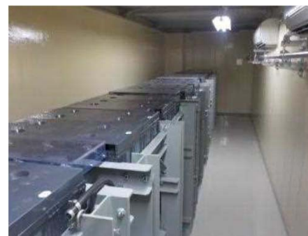
直流125V蓄電池
