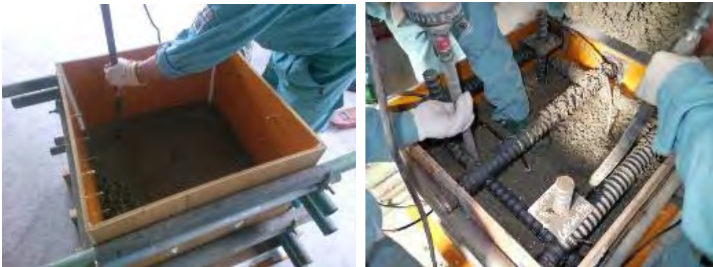
図 4.32 型枠への打設状況
