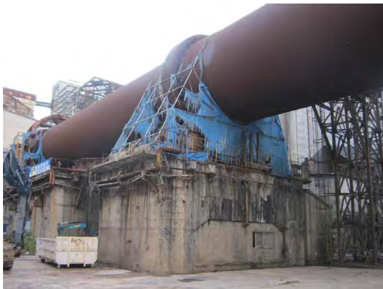
図 4.46 対象構造物の外観状況
