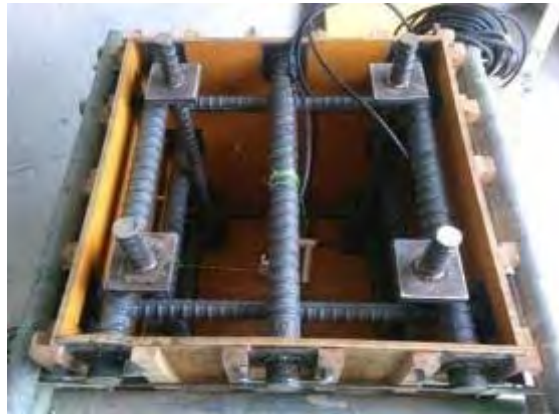
図 4.31 有筋試験体 (T0_5.5_有筋) の型枠内部の状況
