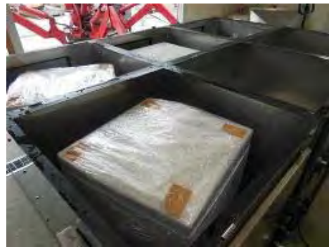
(d) 収納後状況 (この後屋根を設置)
