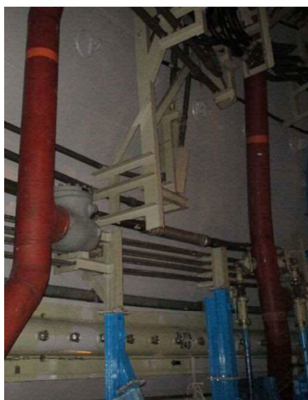
仮設足場組立前
