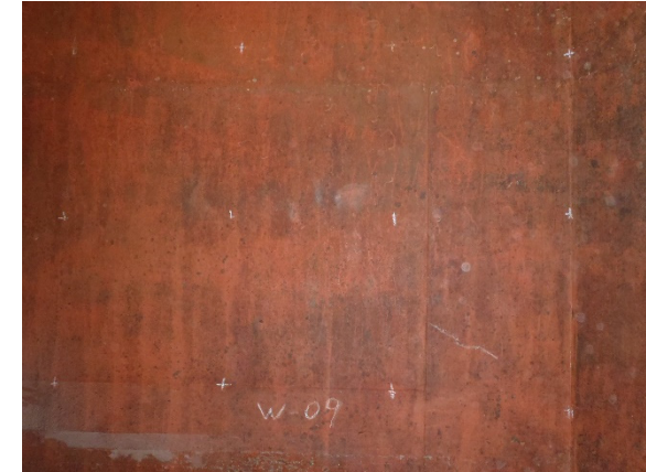
取水槽 海中帯 (壁面)
