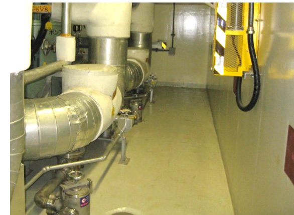
タービン建屋 基礎マット
