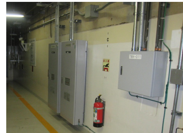
タービン建屋 外壁 (屋内面)
