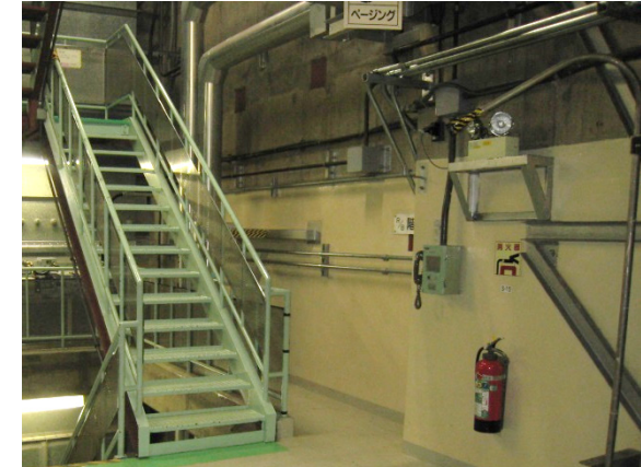
原子炉建屋等 外壁 (屋内面)
