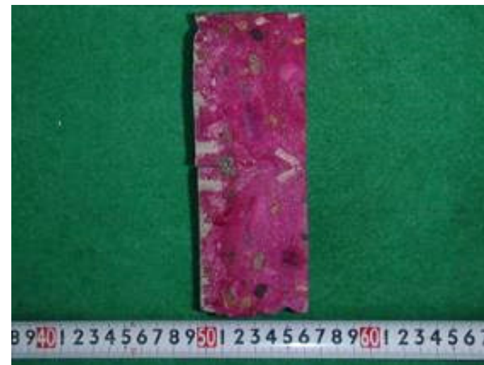
中性化深さの点検状況
