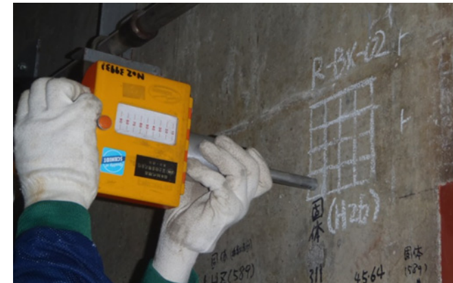
リバウンドハンマーによる試験状況
