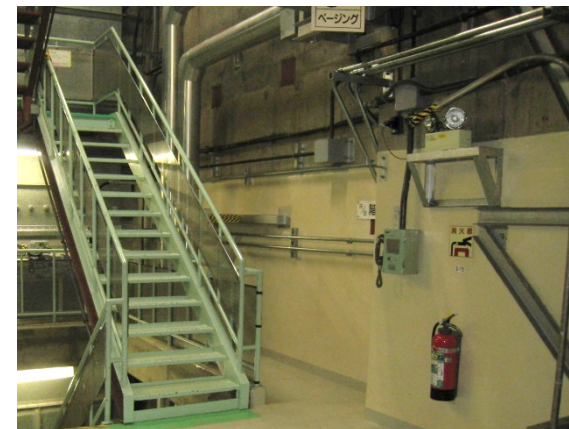
原子炉建屋等 外壁 (屋内面)
