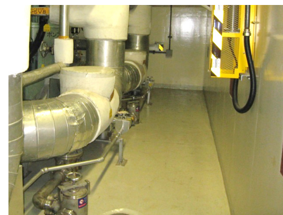
タービン建屋 基礎マット
