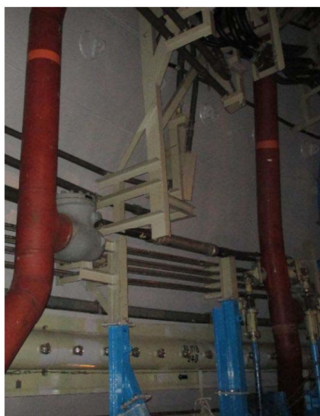
仮設足場組立前
