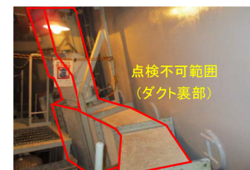
例 点検不可範囲(ダクト裏部)
