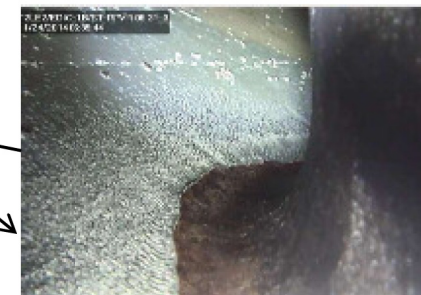
試験結果(CRDスタブチューブの原子炉圧力容器取付け溶接部)
