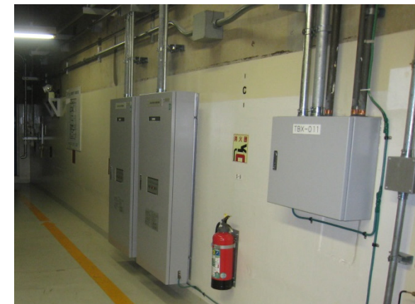
タービン建屋 外壁 (屋内面)
