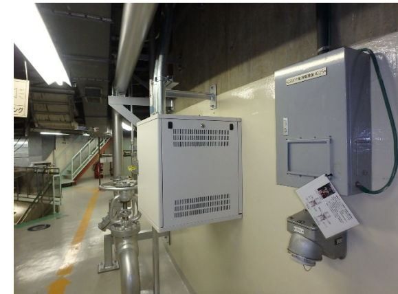
原子炉建屋等 一次遮蔽壁
