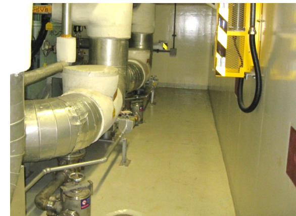
タービン建屋 基礎マット
