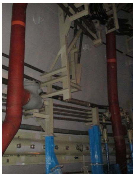
仮設足場組立前
