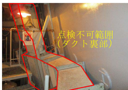
図 5. 1 今回定めた目視試験条件が確保できない範囲（代表例）
