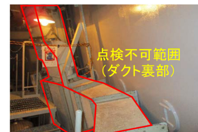
例 点検不可範囲(ダクト裏部)
