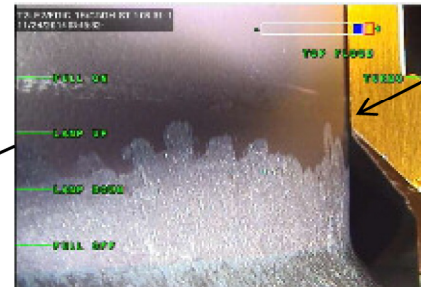
試験結果(CRDハウジングのCRDスタブチューブとの溶接部)
