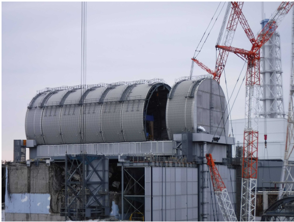
【写真1】ドーム屋根設置前
