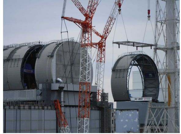
【写真2】ドーム屋根吊り上げ
