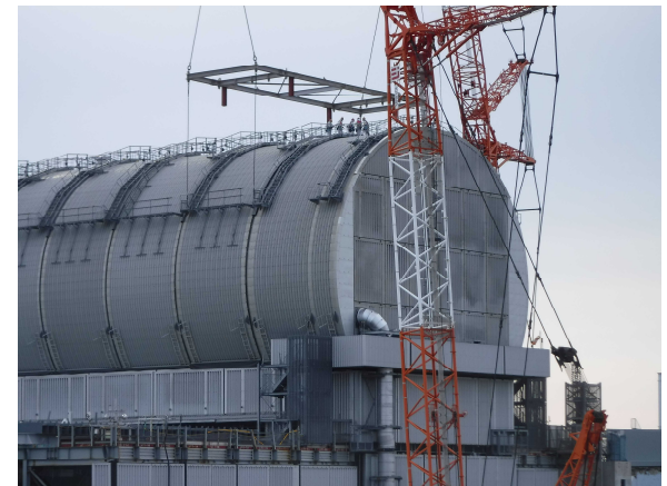
【写真4】ドーム屋根設置完了
