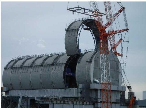
【写真3】ドーム屋根吊り下ろし
