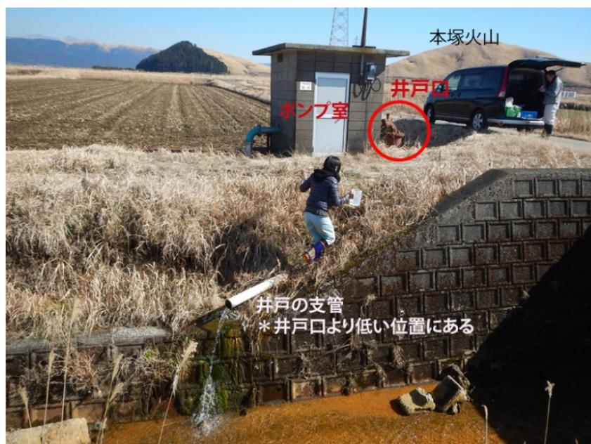
図 A3.2.1.2-1 農閑期に揚水用のポンプを停止させている井戸の状況。支管から流出する地下水が川へ放流されている。
