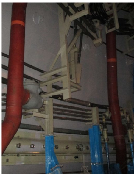
仮設足場組立前
