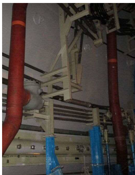
仮設足場組立前
