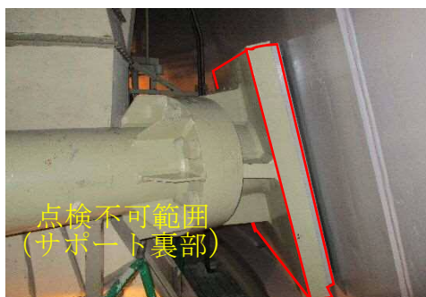
図 5. 2 干渉物等で接近が困難であり今回定めた目視試験条件が確保できない範囲（代表例）
