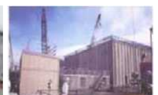
水処理二次廃棄物 (2) （スラッジ）
