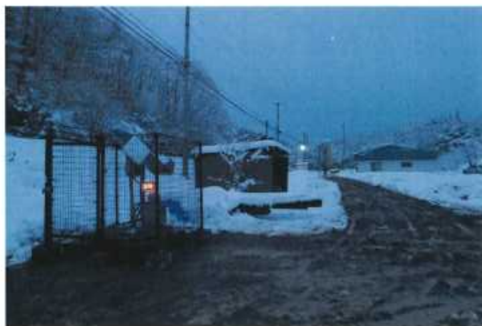
図 2-9-2-10(3) 移設後のモニタリングポスト (八木沢芦原多目的集会所 (飯館村) : 平成 29 年 3 月 15 日撮影)
