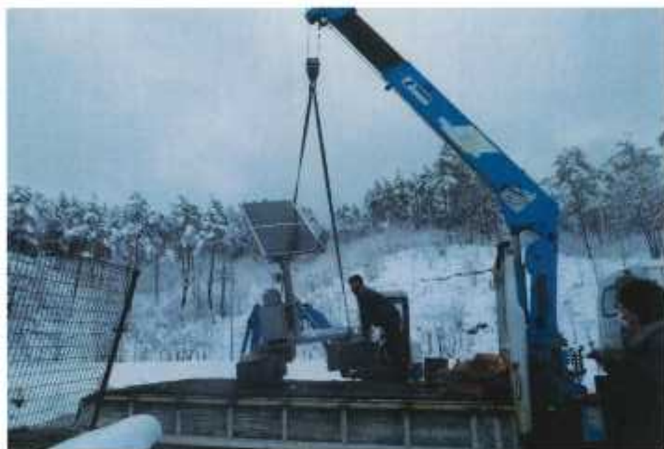
図 2-9-2-10(1) 移設作業の様子 (八木沢芦原多目的集会所 (飯舘村))
