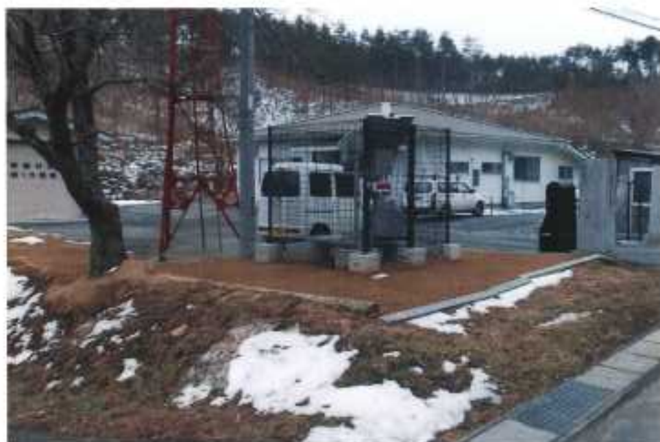
図 2-9-2-10(2) 移設前のモニタリングポスト (八木沢芦原多目的集会所 (飯館村) : 平成 27 年 1 月 15 日撮影)
