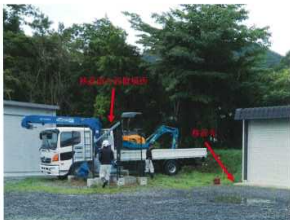
図 2-9-2-9(1) 移設作業の様子 (小宮コミュニティセンター (飯館村))
