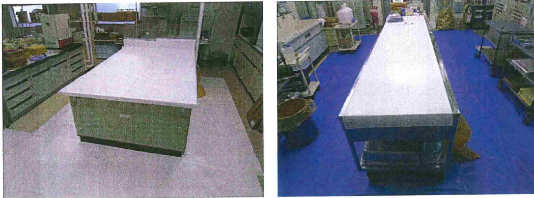
図 4. 3. 21 作業室内の養生例
