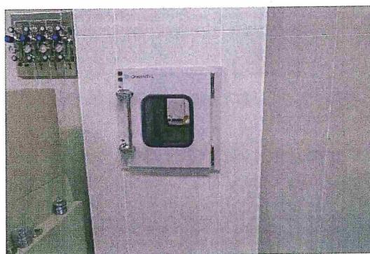
図 4.3.24 測定試料受け渡し用パスボックス
