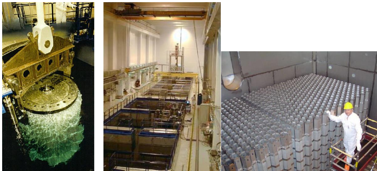
図表 53: Loviisa 原子力発電所のサイト内にある使用済み燃料貯蔵プール
