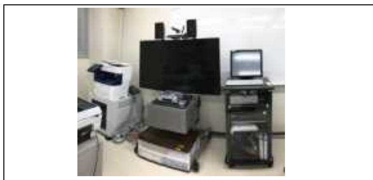
図1：統合ネットワークシステム設置写真
