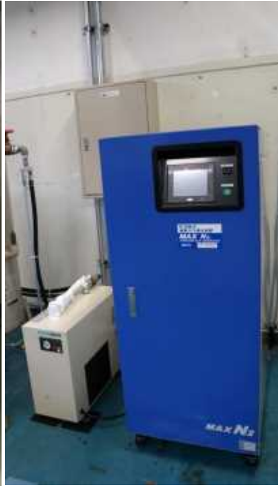
(b) エアードライヤ窒素発生器
