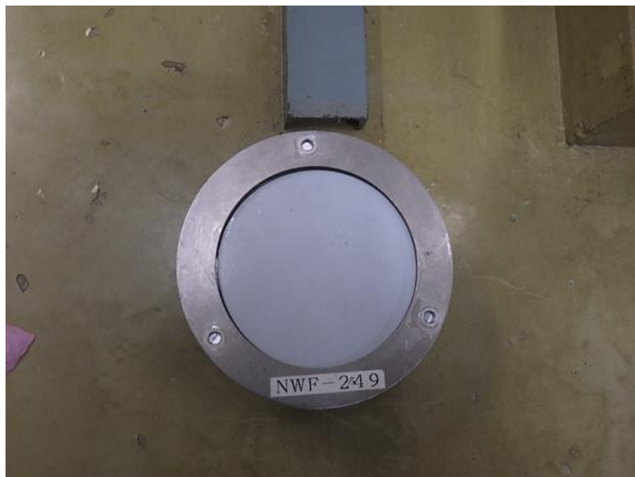
NRW-I 地下1階 南西側エリア
