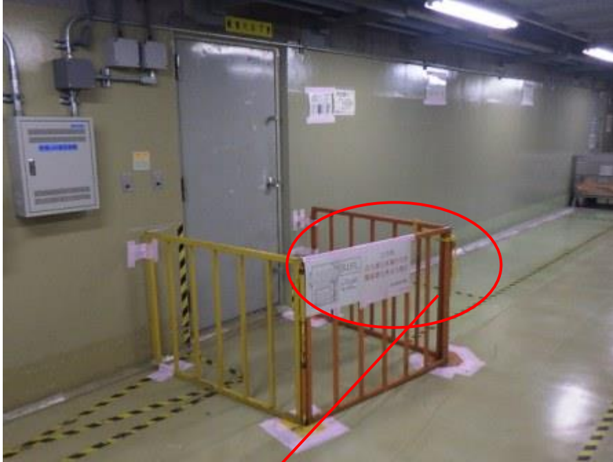
<NRW- I 地下1階 西側通路>
