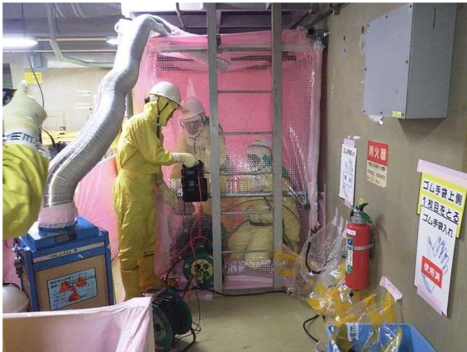
<NRW- I 地下2階 南西側エリア>
