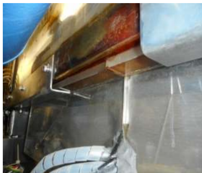
図7 背面カバー接合部のずれ
