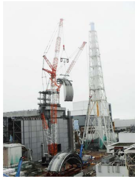
【写真4】ドーム屋根吊り上げ②
