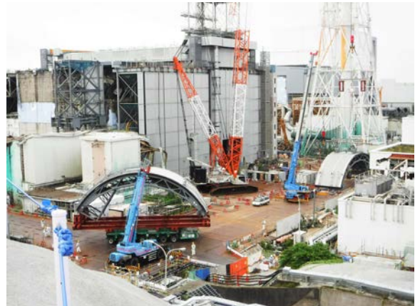
【写真2】ドーム屋根南側片 構内輸送
