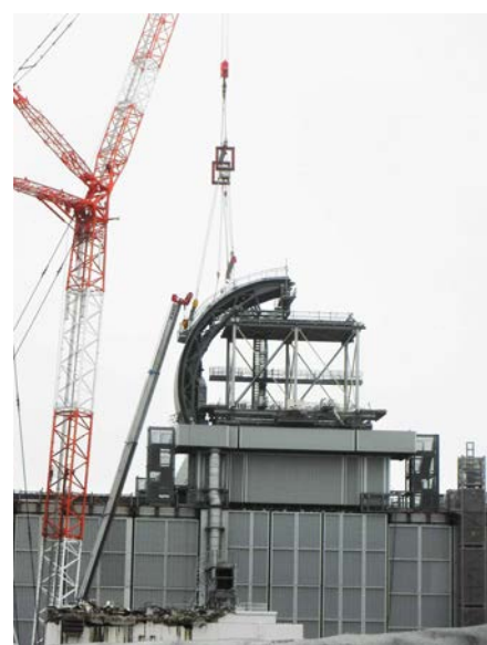
【写真6】ドーム屋根北側片設置
