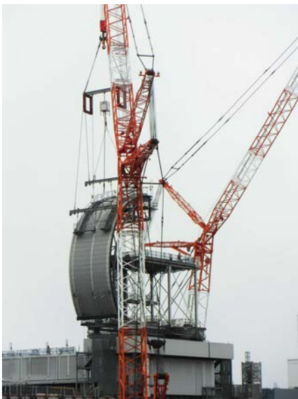
【写真5】ドーム屋根吊り上げ③
