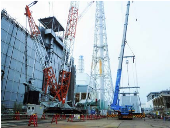
【写真1】吊り上げ前のカバー(7/30撮影)
