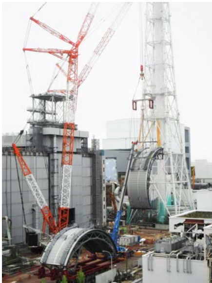
【写真3】ドーム屋根吊り上げ①
