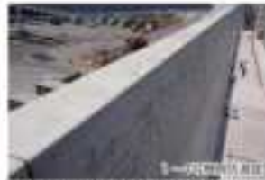
図1 防壁の建設(新潟県柏崎の例)
