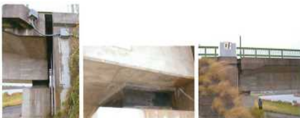
図 2-4 平成大橋の橋台部
