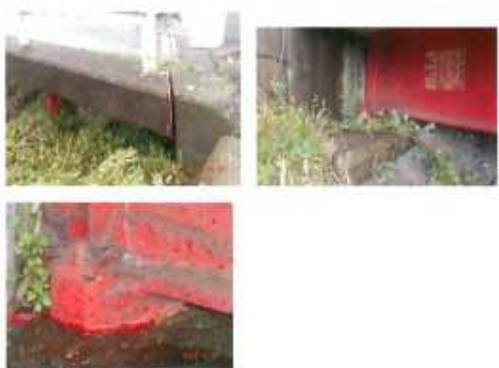
図 2-3 芋川一の橋の橋台部
