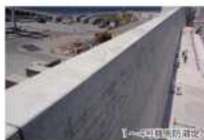
図1 防潮堤の建設(柏崎刈羽の例)
