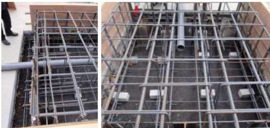
写真 4.3.1 反力壁の配筋の状況
