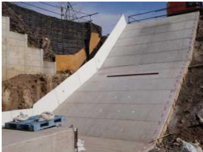
写真 8.1.5 30 度部にアンゲル材を設置した状況
