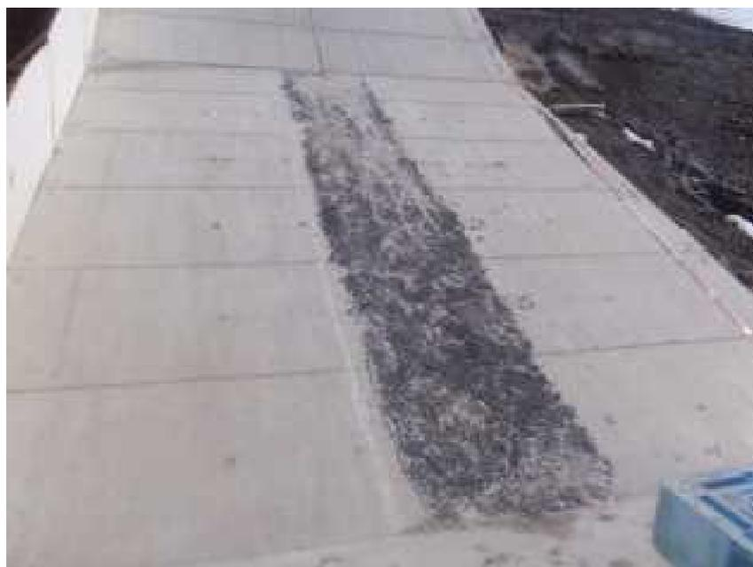
写真 8.1.6 30 度部に凹凸を設置した状況
