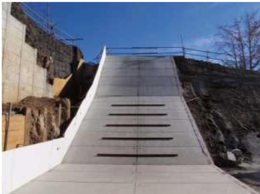
写真 8.1.4 アングル材設置状況
