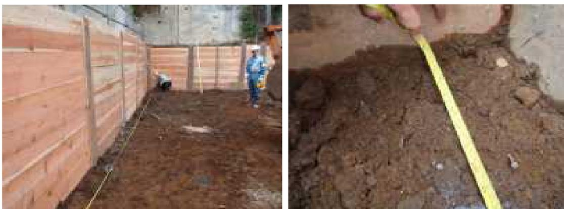
写真 4.1.3 平坦部幅の検査状況
