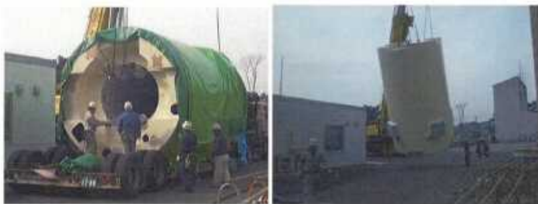
図 15 電力中央研究所 赤城試験センターでのコンクリートキャスク (内部にコンクリートを打設する前の鉄製部分のみ) 輸送・設置状況の例 (25)
