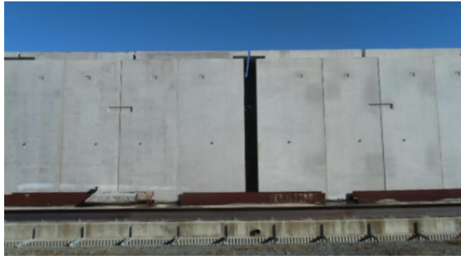
図 2.1-4 セシウム吸着装置（KURION）吸着塔保管状況
