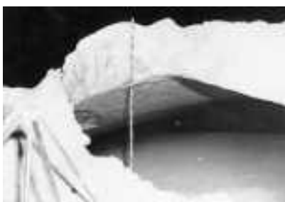
図 1.8-4 地下 553m で坑道の下面が突き出た状態
