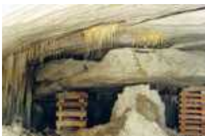
図 1.8-3 地下 700m の岩盤の緩い箇所等
