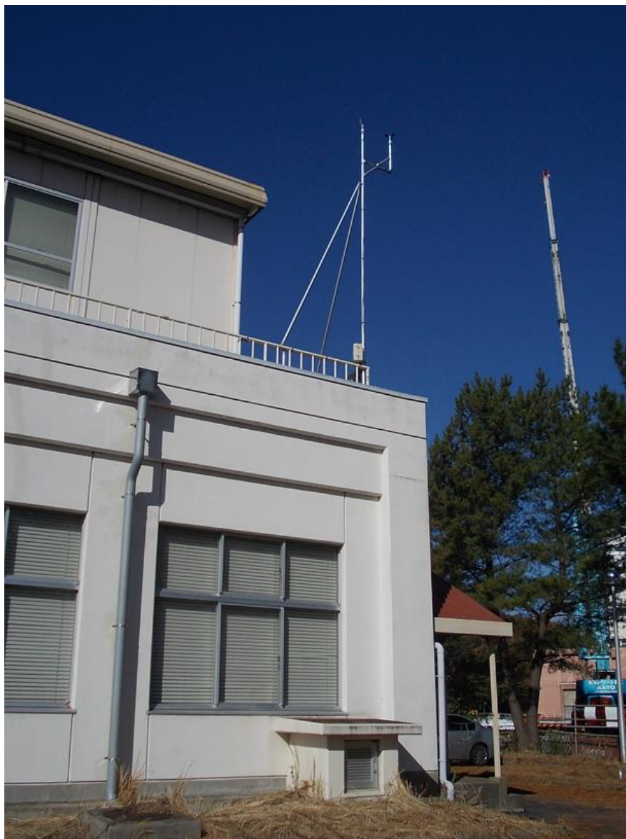
図 4.4-13 環境シミュレーション試験棟屋上に設置した増設風向風速計
