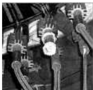
ヒータ下部に浸み出したホウ酸
