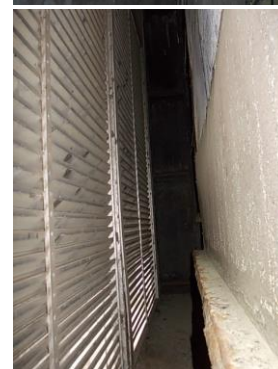
図 4.6-3 環境シミュレーション試験棟の「建屋 OA 吸気ダクト」
