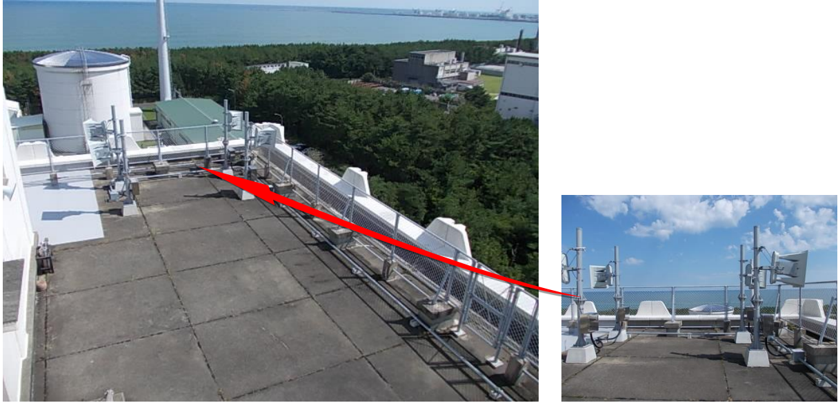
図 4.5-7 安工棟屋上の増設気中塩分モニタリング装置設置環境
