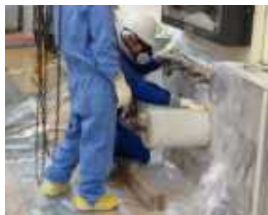
専用遮蔽プラグ交換作業
