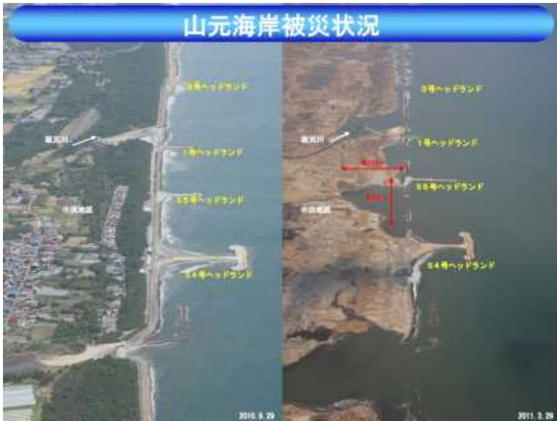
図 6-9 : 仙台湾南部海岸における津波前後の航空写真. 左 : 被災前 (2010 年 9 月), 右 : 被災後 (2011 年 3 月). 出典 : 東北地方整備局, 仙台湾南部海岸の被災状況.
