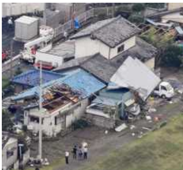
図 4.3.1 ダウンバーストによる被害 (2015 年 6 月群馬県伊勢崎市[4.3.1])
