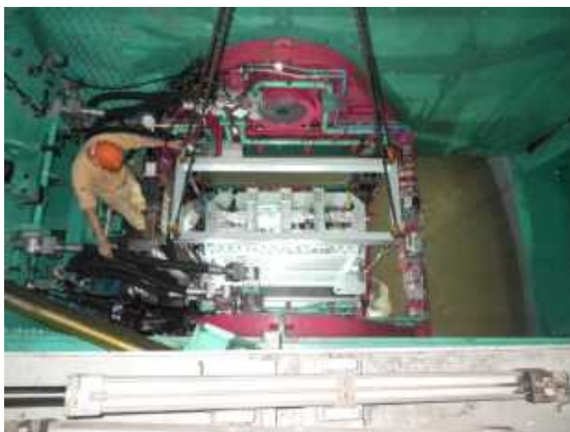
写真 3.1.35 ケース 32 土槽据え付け状況
