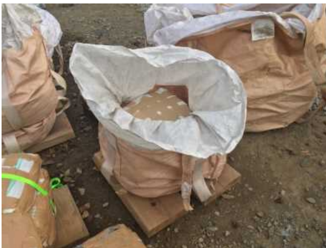
図 3.2.33 トンパック(土のう詰め)
