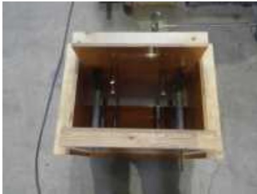
写真 3.1.1 型枠作製 (ケース 32)
