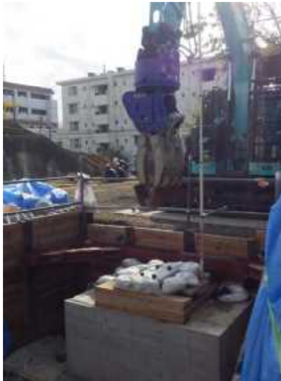
図 3.2.66 コンクリート板 実岩塊模型 20cm 試験状況
