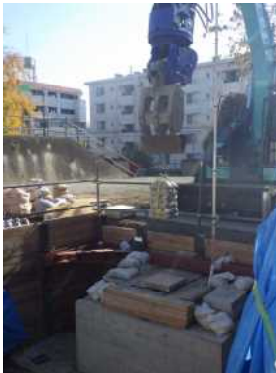
図 3.2.72 コンクリート板 土砂模型（土のう 6 段） 試験状況
