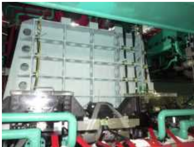
写真 3.1.48 ケーブル配線状況
