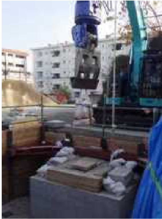
図 3.2.63 ベニヤ板 土砂模型（トンパック土のう詰め） 試験状況
