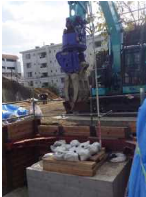
図 3.2.68 コンクリート板 多面体岩塊模型 20cm 試験状況
