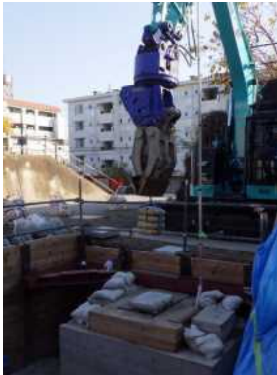
図 3.2.71 コンクリート板 土砂模型（土のう 4 段） 試験状況
