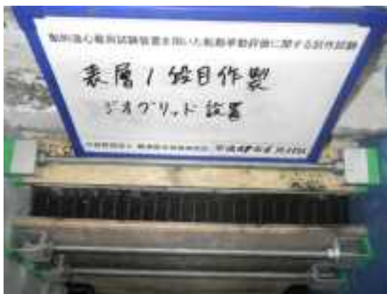
写真 3.1.26 表層部補強材敷設状況 1
