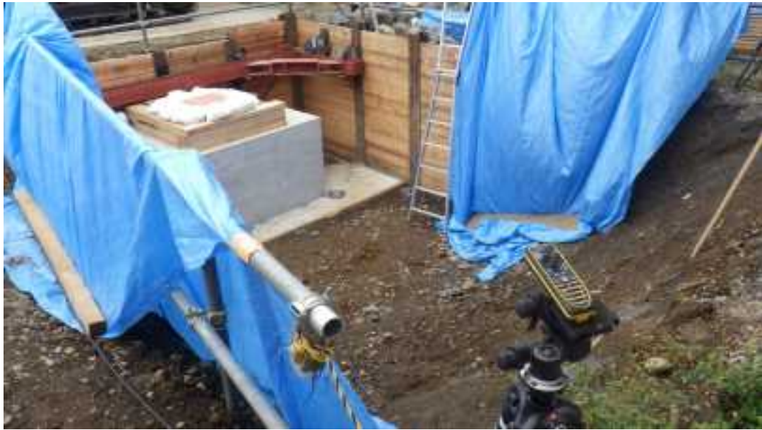
図 3.2.50 レーザー距離計設置状況
