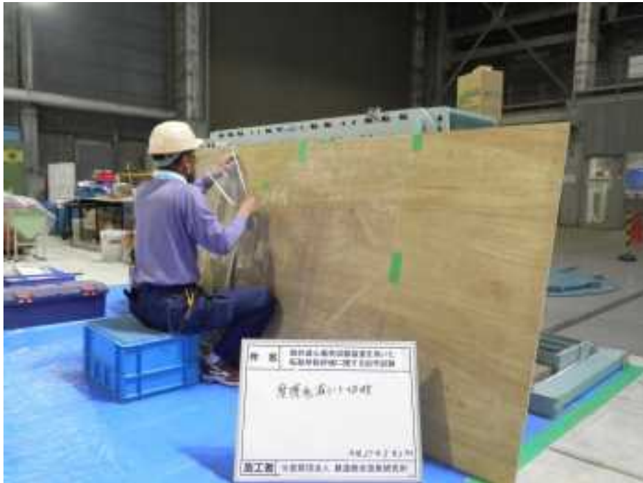
写真 3.1.17 トヨフロンシート切断
