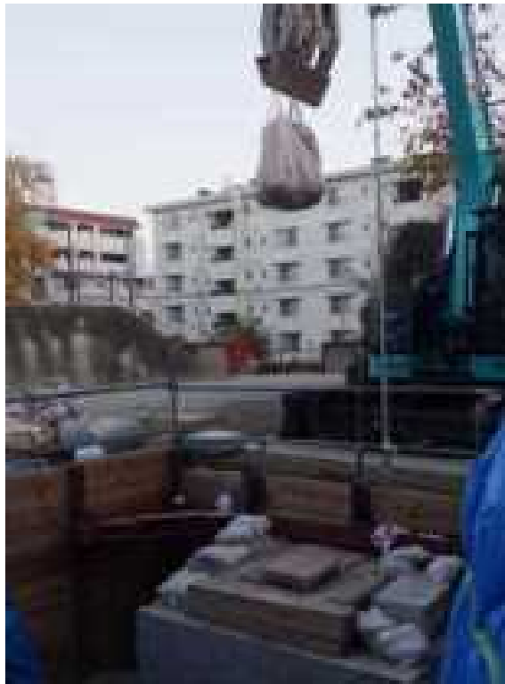
図 3.2.62 ベニヤ板 土砂模型（トンパック） 試験状況
