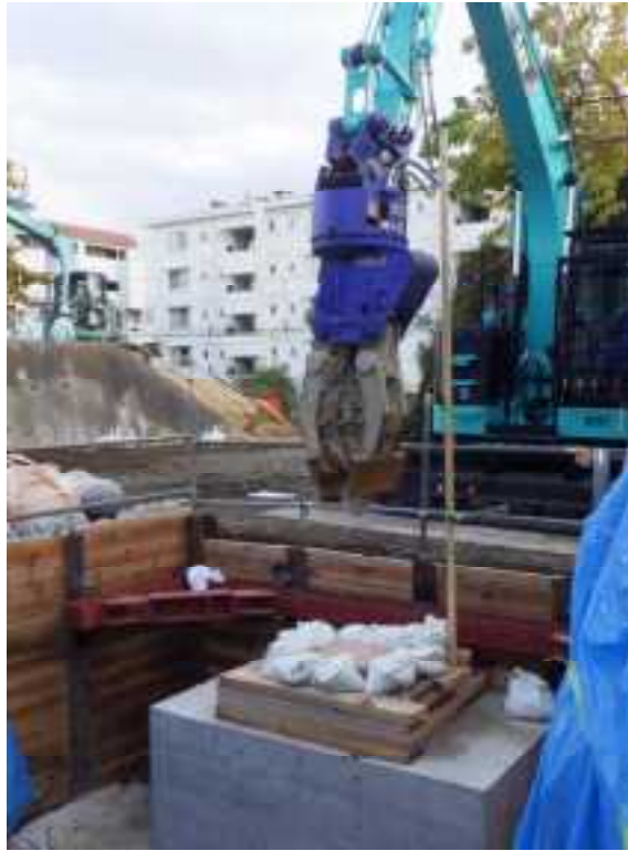
図 3.2.55 ベニヤ板 実岩塊模型 20cm 試験状況
