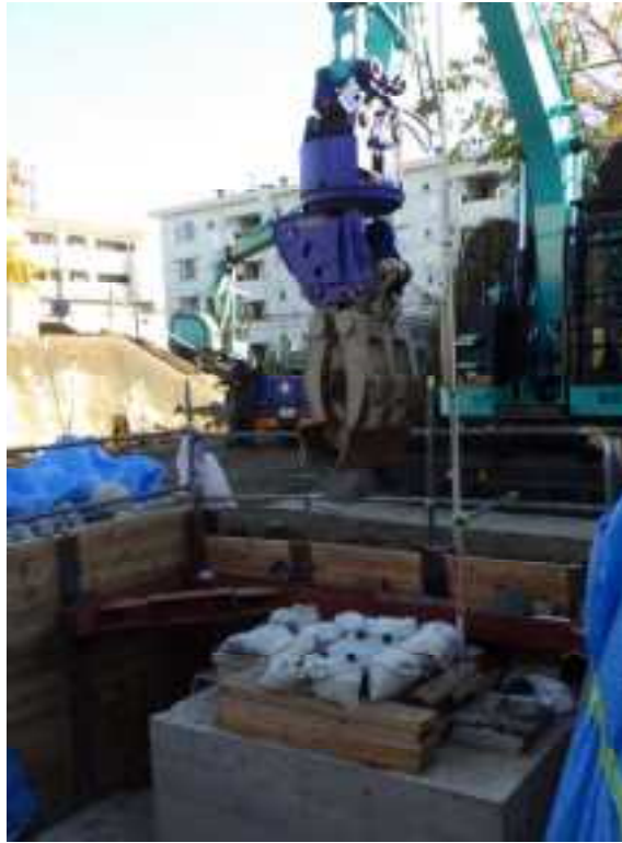
図 3.2.67 コンクリート板 実岩塊模型 40cm 試験状況
