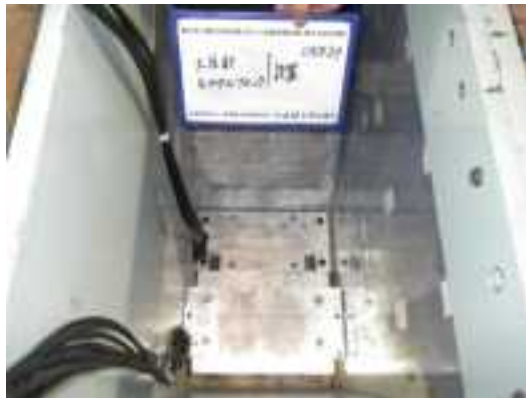
写真 3.1.9 設置状況 1 (ケース 33)
