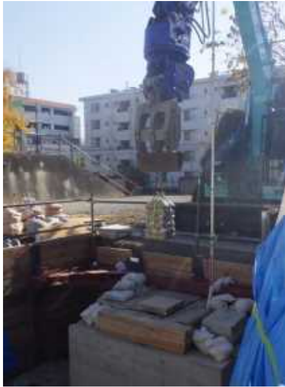
図 3.2.61 ベニヤ板 土砂模型（土のう 6 段） 試験状況
