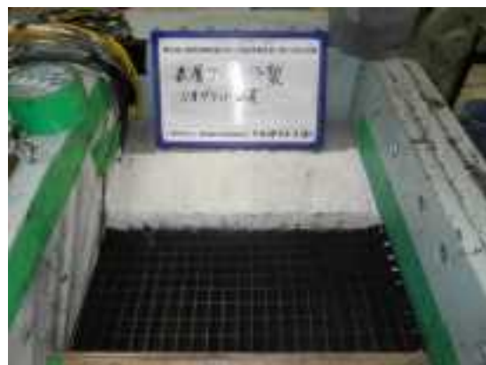
写真 3.1.27 表層部補強材敷設状況 2
