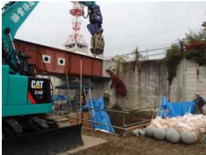
図 3.2.51 落下高さ計測状況
