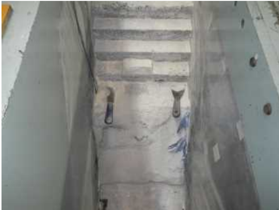
写真 3.1.41 ケース 33 土試料のサンプリング状況 2
