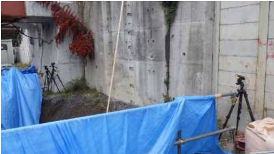
図 3.2.49 レーザー距離計設置状況
