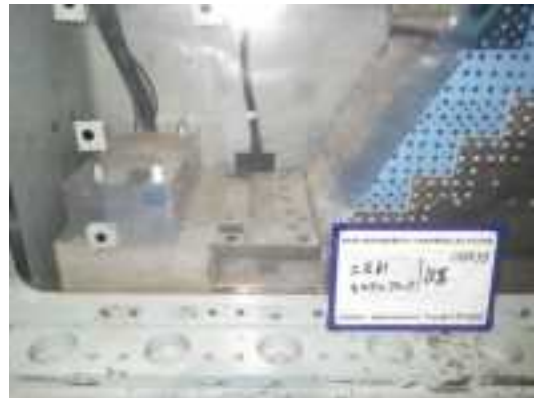
写真 3.1.10 設置状況 2 (ケース 33)
