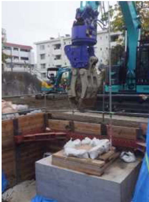
図 3.2.56 ベニヤ板 実岩塊模型 40cm 試験状況
