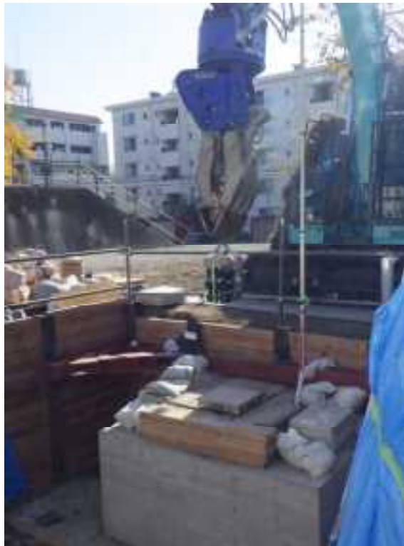
図 3.2.60 ベニヤ板 土砂模型（土のう 4 段） 試験状況
