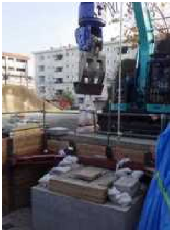
図 3.2.74 コンクリート板 土砂模型（トンパック土のう詰め） 試験状況
