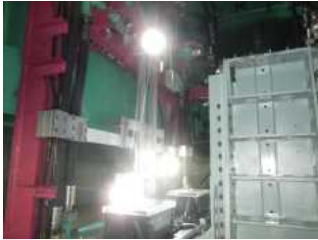
写真 3.1.47 照明設置状況 2
