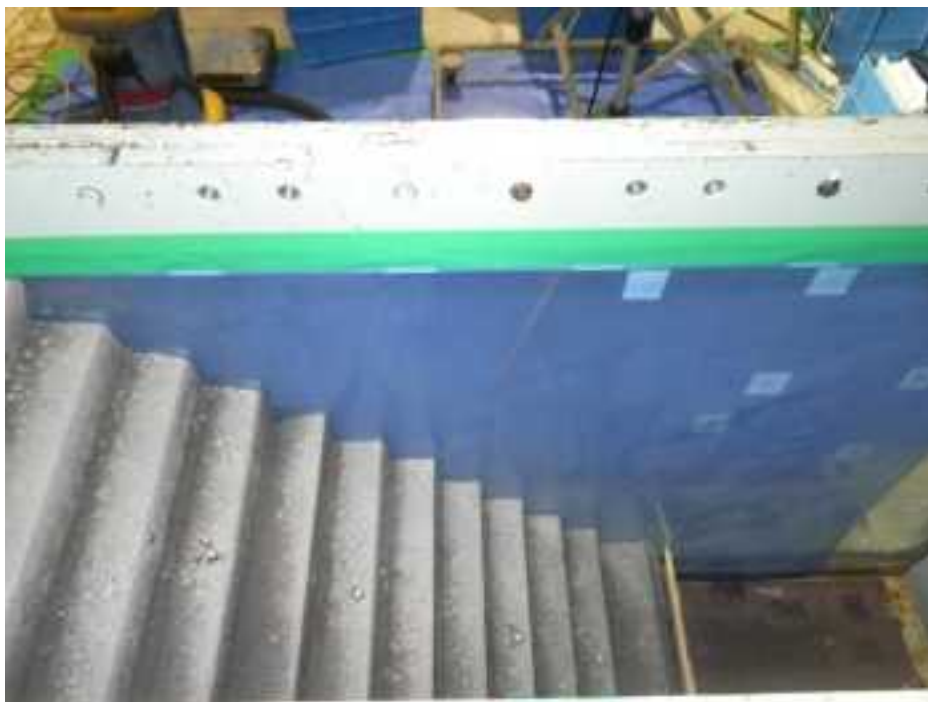
写真 3.1.20 セイデンブルーシート貼り
