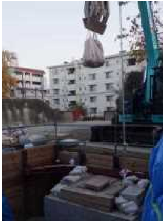
図 3.2.73 コンクリート板 土砂模型（トンパック） 試験状況
