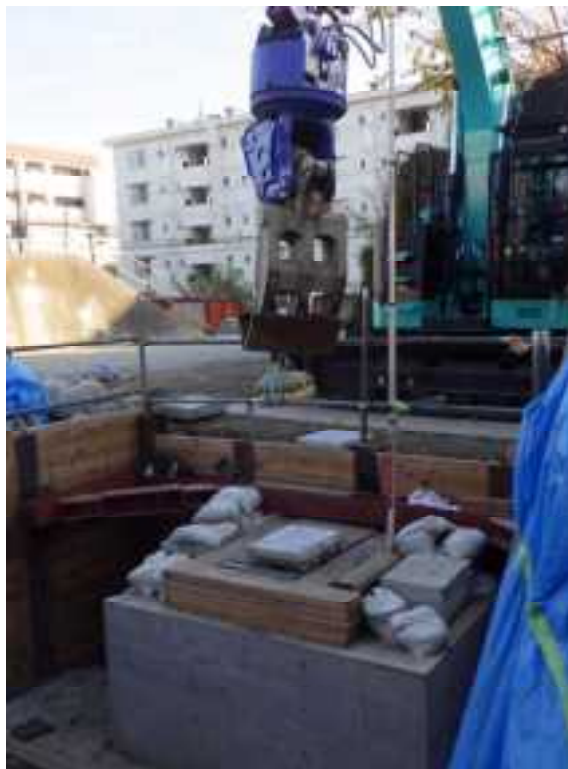
図 3.2.70 コンクリート板 土砂模型（土のう 2 段） 試験状況
