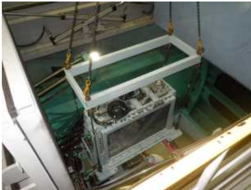
写真 3.1.37 ケース 33 土槽据え付け状況
