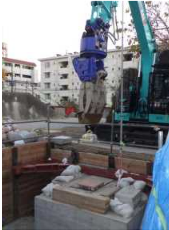
図 3.2.59 ベニヤ板 土砂模型（土のう 2 段） 試験状況
