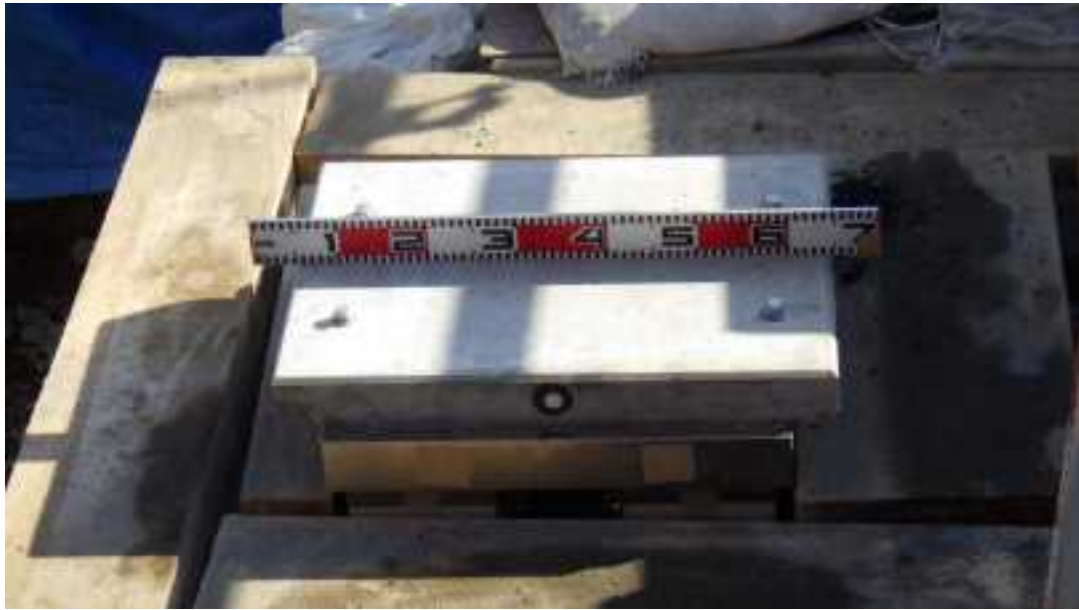
図 3.2.48 固定点および距離補正用スケール設置状況
